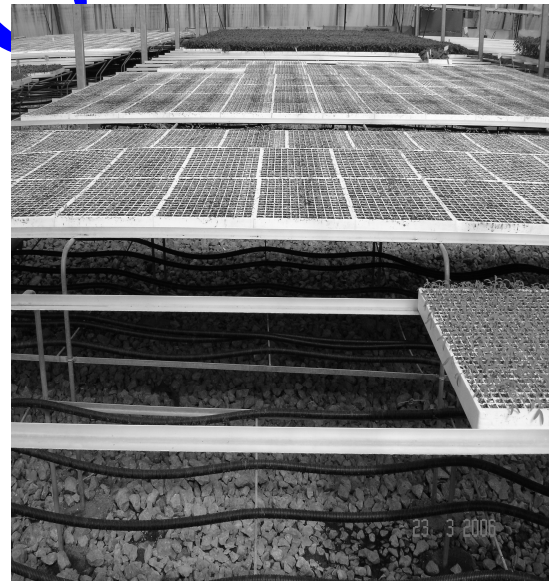
Εικόνα 4. Θέρμανση μέσω σωλήνων ζεστού νερού
