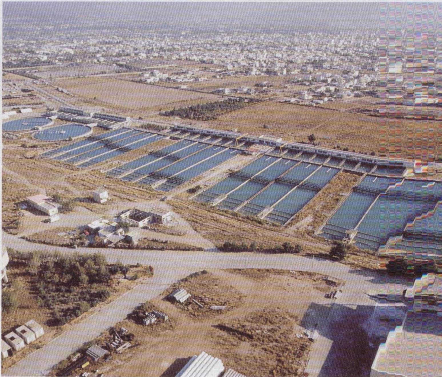
Μονάδα Επεξεργασίας Νερού Μενιδίου Φωτό 2000
