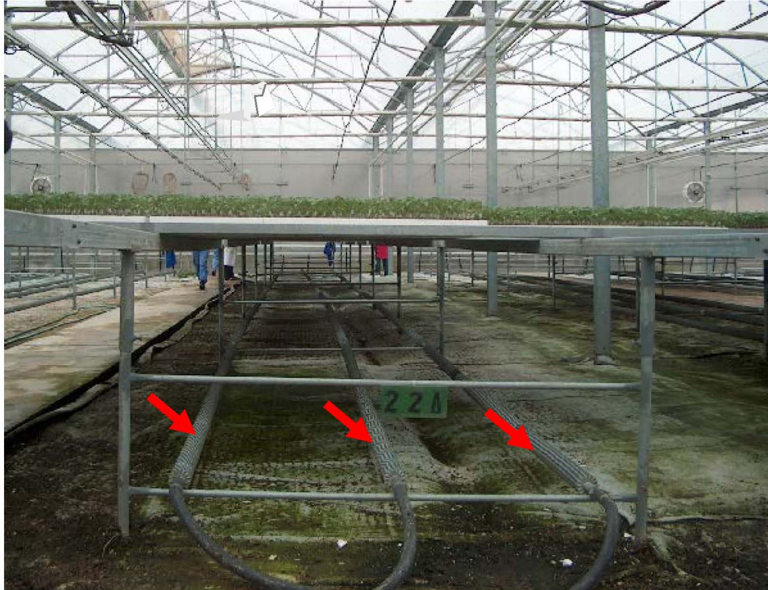
Πτερυγωτοί μεταλλικοί σωλήνες θέρμανσης κάτω από το τραπέζι καλλιέργειας
